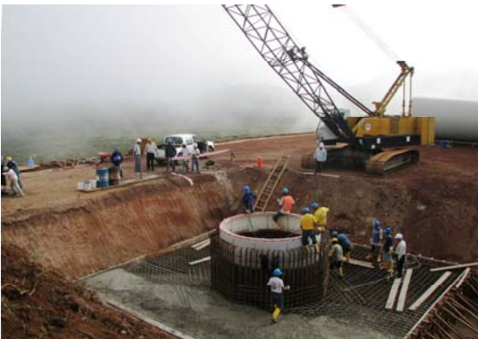
Cimentaciones de aerogeneradores
