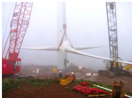
Montaje de las aspas
